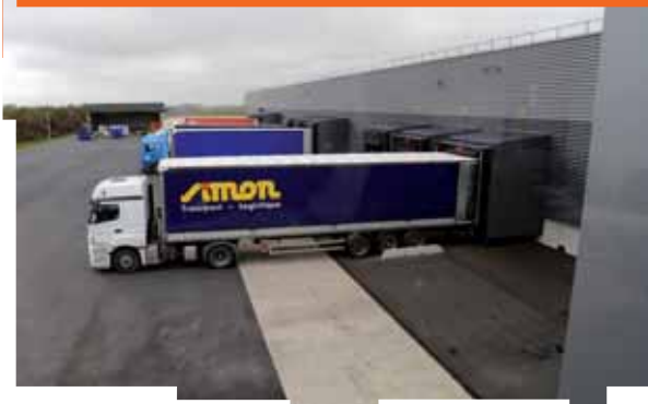
La plate-forme logistique charge et décharge environ 8 000 camions par an.
